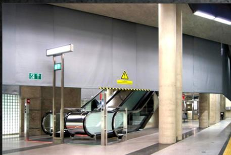
К числу современных способов защиты от пожара относятся противопожарные шторы. Это сравнительно новый вид противопожарной преграды, но они все чаще находят большое применение в современных проектах нового строительства и реконструкции уже эксплуатирующихся зданий.
